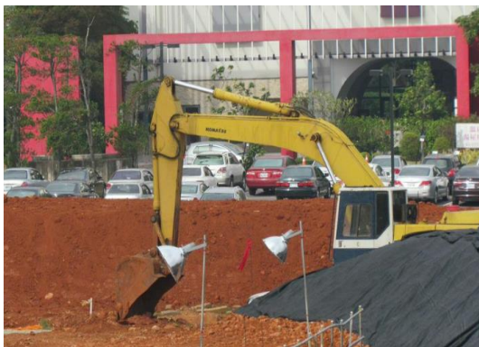
耗資 6 億台幣的第二期宴會廳工程
