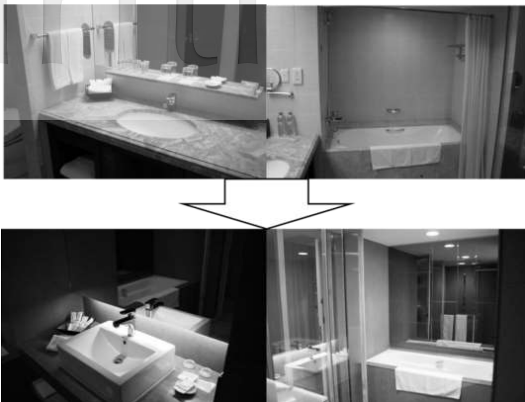
圖 3 浴室廁所裝修前後對照圖
