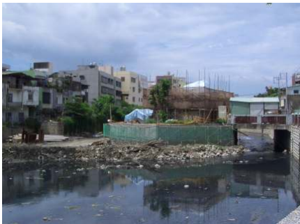
圖 10 修復中的東便門與東福橋
