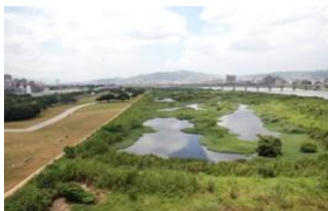
新海橋人工溼地
